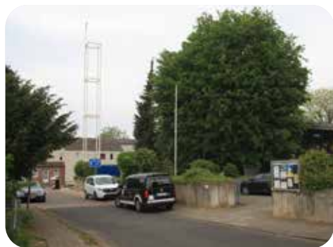
Sanitärcontainer an der Gnadenkirche
