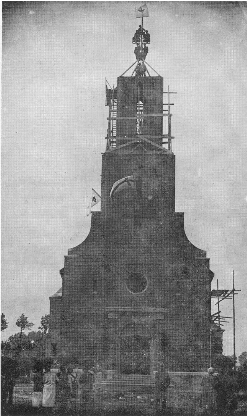
Am 21. Januar 1927 wird Richtfest gefeiert
